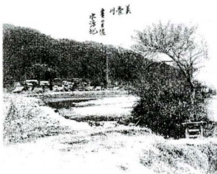
亀之井用水水源地
