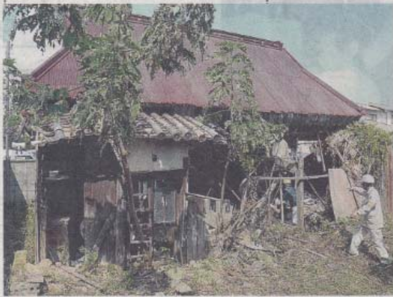
解体作業が始まった空き家＝高砂市北浜町西浜
