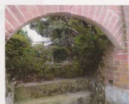
▲アーチ型にくり抜かれたこの空間で、かつては荷物の運び込みが行われていました。
