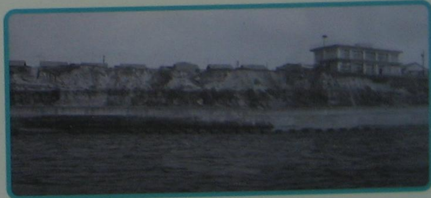
侵食防止のため護岸整備をした頃の藤江海岸（昭和39年）
