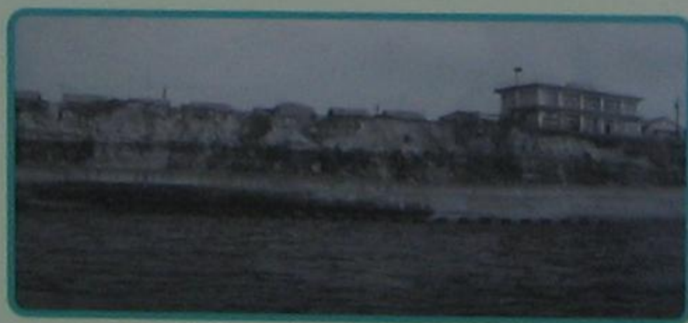
侵食防止のため護岸整備をした頃の藤江海岸（昭和39年）
