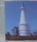
磨万津灯台 明治17年(西)に建てられた。
