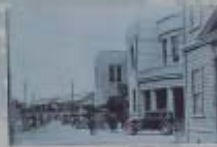
磨飾町庁舎・磨飾市役所 大正10年(西)に建てられた。
